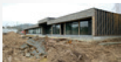
Poursuite des travaux de la Maison des Associations
